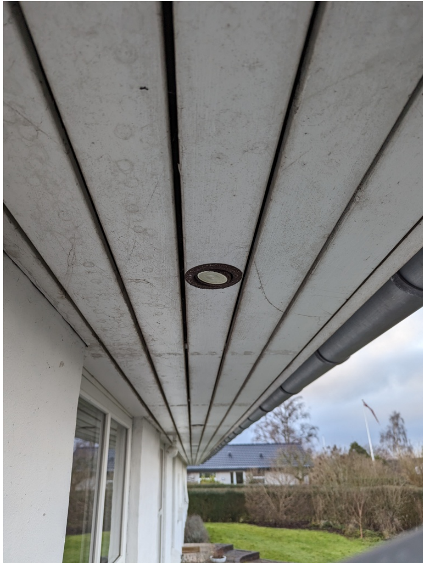
Figure 14: Detalje, underside af udhæng nordlige side
