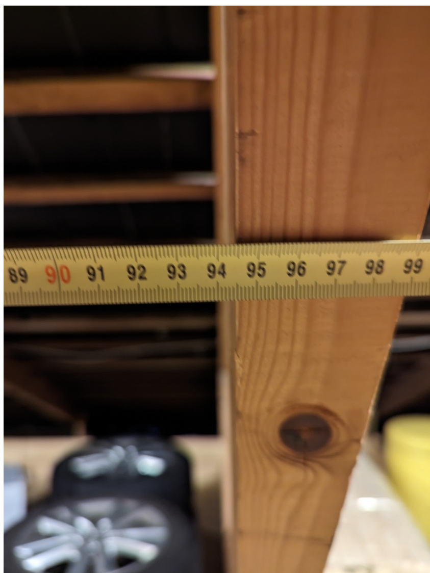
Figure 18: Afstand imellem spær, 94,5cm.
