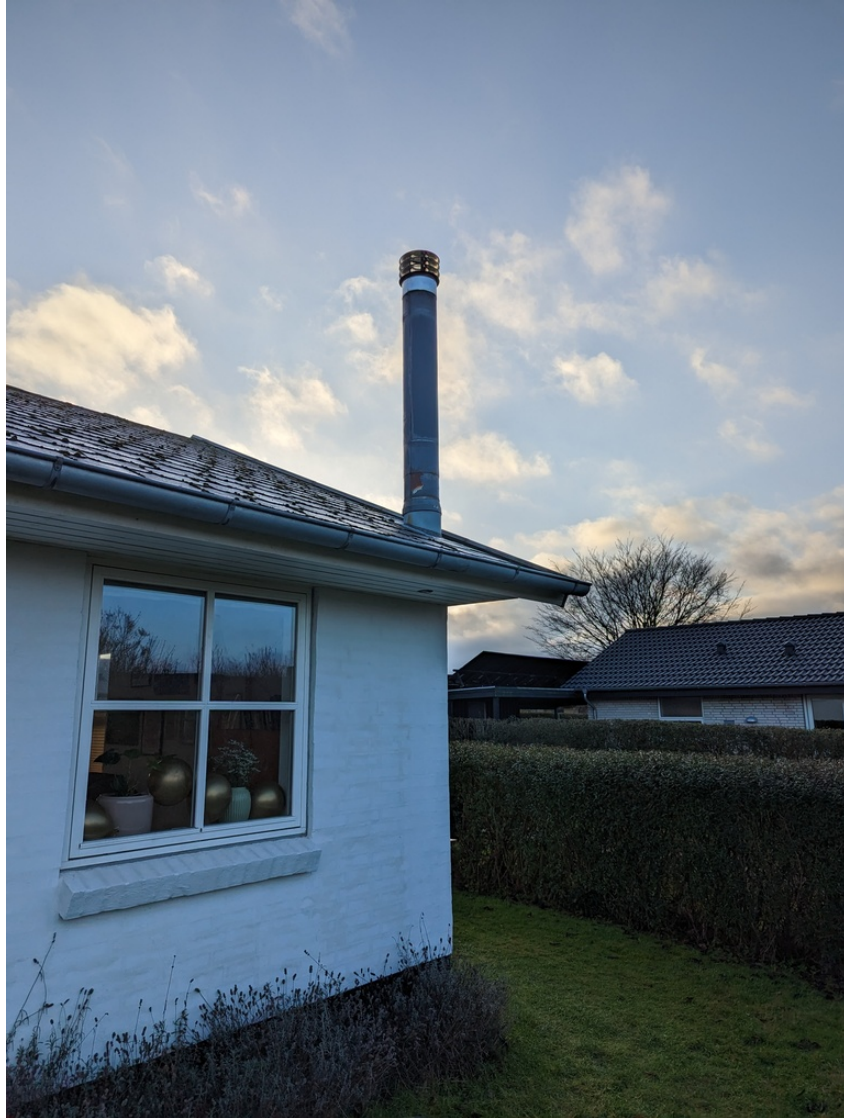
Figure 6: Skorsten ønskes fjernet.
