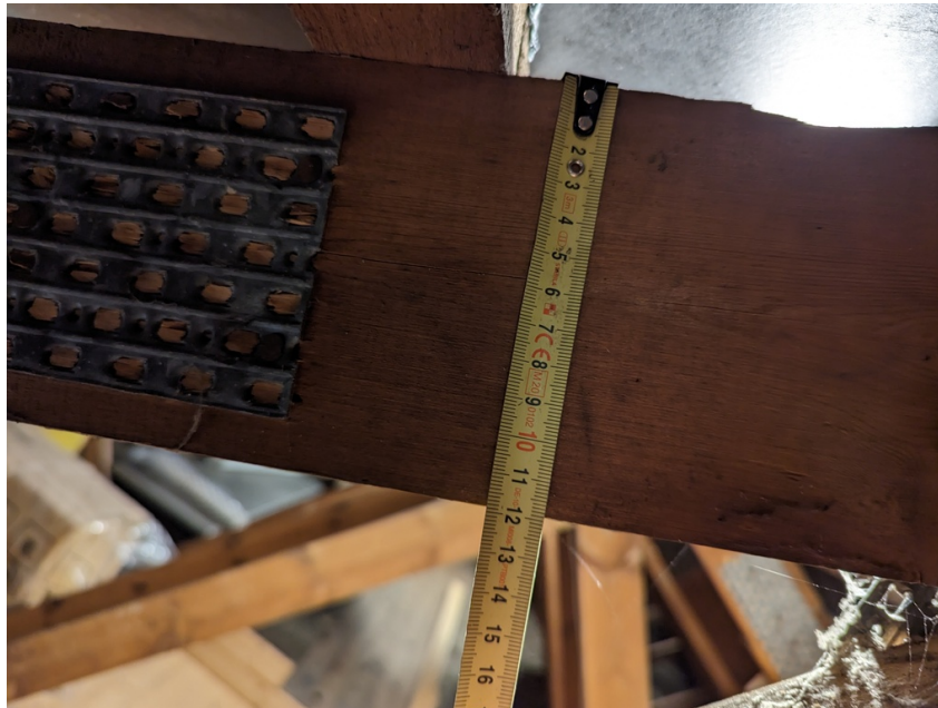
Figure 16: Spær som bærer tag direkte, 12cm tykkelse
