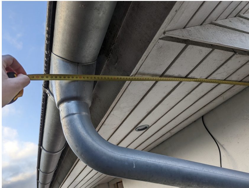
Figure 12: Taget på lange led stikker ca. 85-90cm ud fra muren.
